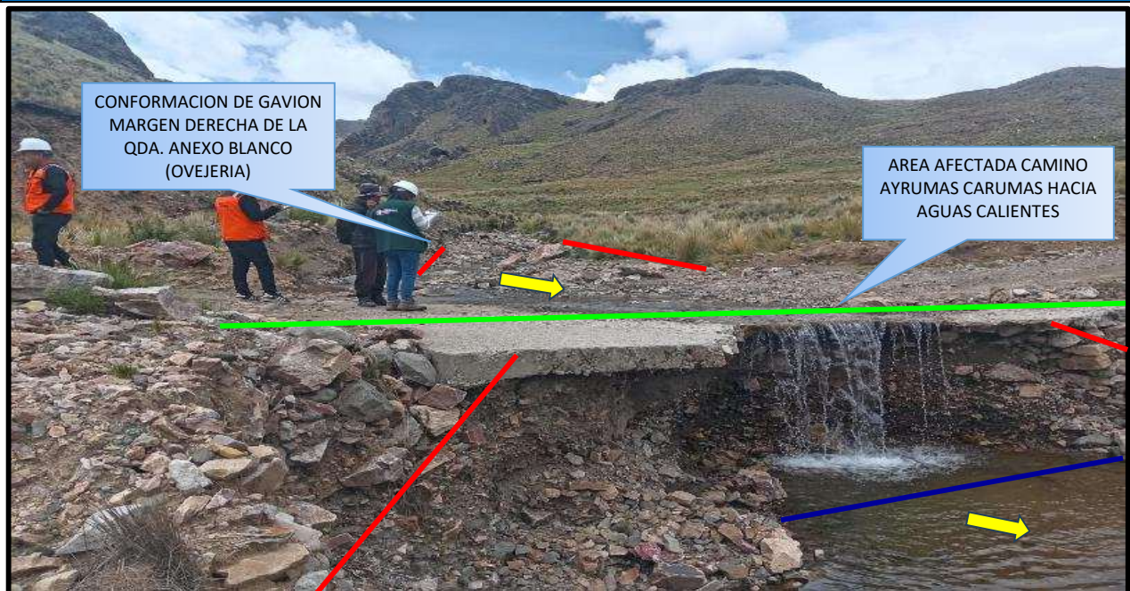
FIGURA N° 01: La imagen evidencia un proceso de colmatación en el badén, con acumulación de sedimentos gruesos (gravas y bloques) transportados por el flujo del río. Se observa arrastre de material que ha generado socavación en la base y márgenes, debilitando la estructura y provocando erosión regresiva. Como consecuencia, el incremento del caudal ha ocasionado el desborde del badén, deteriorando la plataforma y comprometiendo la transitabilidad.
